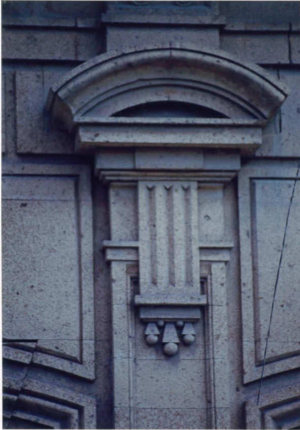
FOTOGRAFÍA 32. Detalle del diseño de cantería en fachada. Pilastra con fuste moldurado con capitel en forma de frontón con arco rebajado del cual pende un triglifo.
