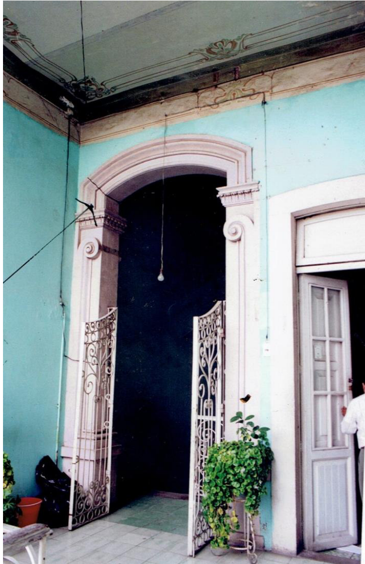
FOTOGRAFÍA 11. Ornamentación en planta alta
