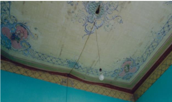
FOTOGRAFÍA 30. Cielo raso en plafón con diseño art. Nouveau. Existen instalaciones eléctricas deficientes que ponen en riesgo la integridad del edificio.
