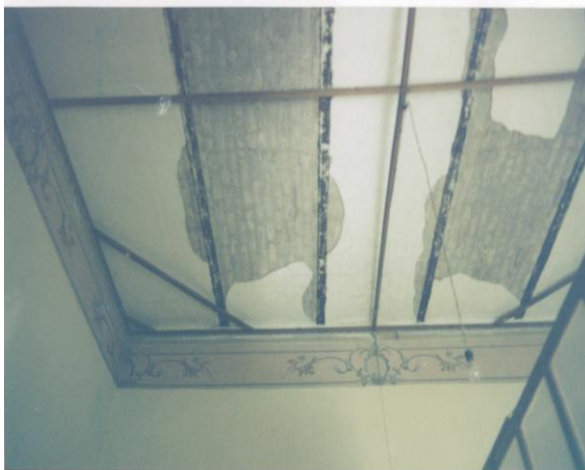
FOTOGRAFÍA 28. Espacio en planta alta con una cenefa superior alrededor del mismo con diseños delicados. El sistema constructivo al perderse el recubrimiento queda de manifiesto, se observan las vigas metálicas y las bóvedas escarzanas.
