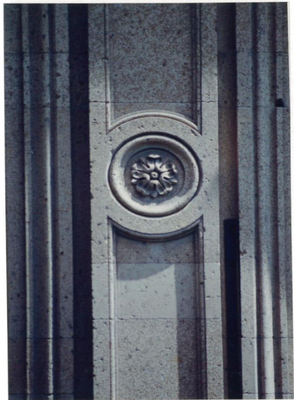
FOTOGRAFÍA 33. Detalle de pilastra de cantería en fachada
