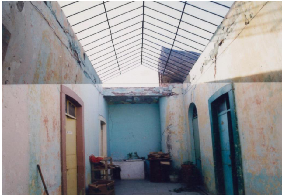
FOTOGRAFÍA 36. Zona de servicios
