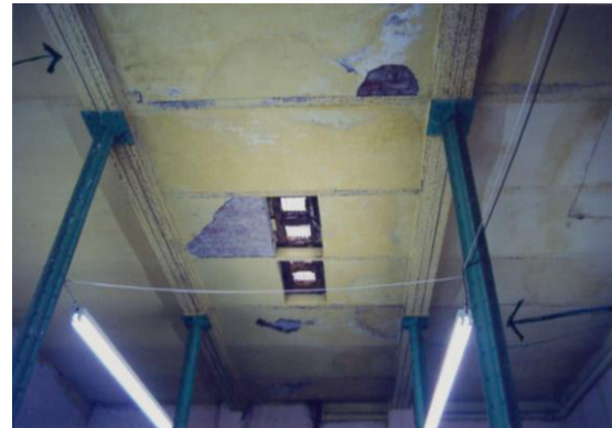
FOTOGRAFÍA 35. Sistema constructivo del inmueble con bóvedas de ladrillo y columnas metálicas remachadas.
