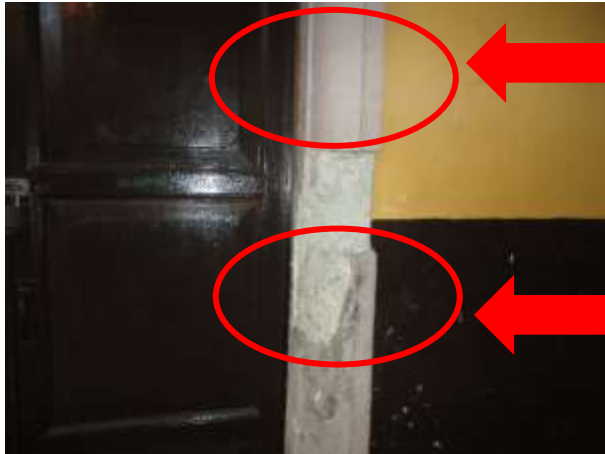
Pintura de aceite en jambas.
