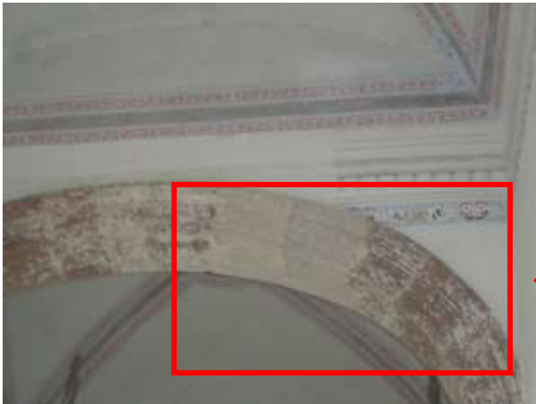
Limpieza y retiro de capas de pintura vinílica.
