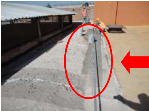
Colocación de malla en muro de colindancia con la Parroquia.
