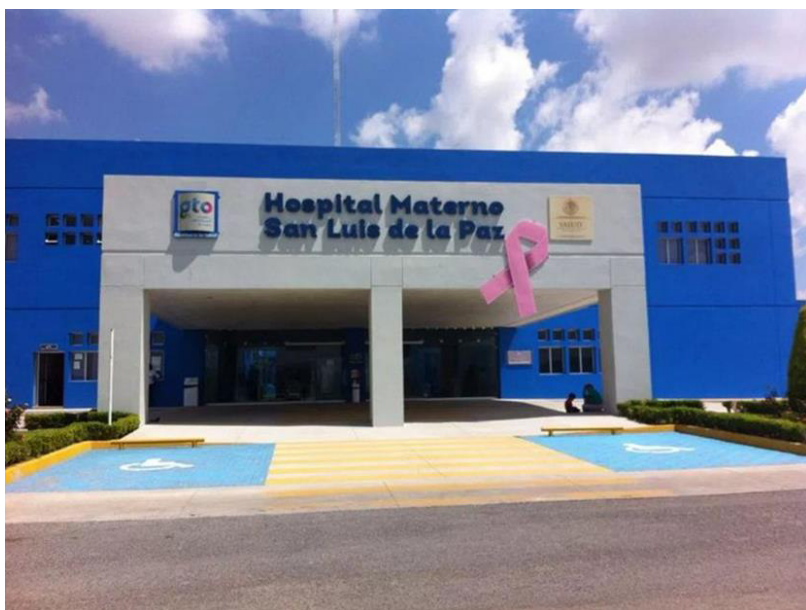
Figura no. 3 Fachada del Hospital Materno San Luis de la Paz, Guanajuato
