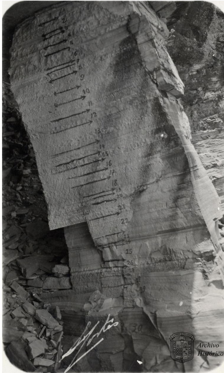
Figura 2.1.10 Veta de cantera en el que se marcaron con tinta las losas, c. 1920 56
