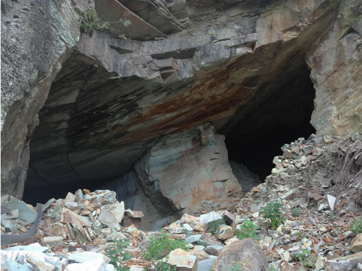
Figura 2.1.7 Banco de San Francisco en los terrenos de la familia Aguilar, clausurado debido a debilitamiento estructural, ya no puede ser explotado. Fotografía propia.
