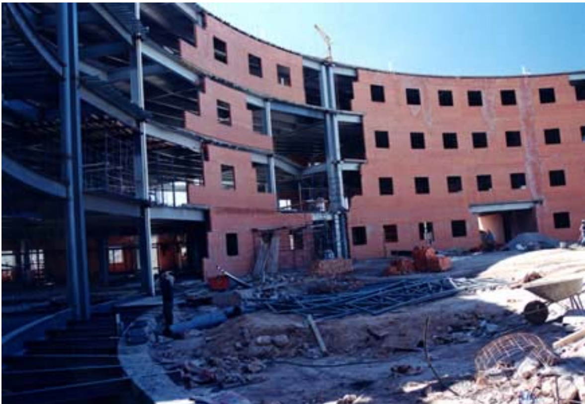
Ilustración 14 Construcción de la U.C.E.A.
