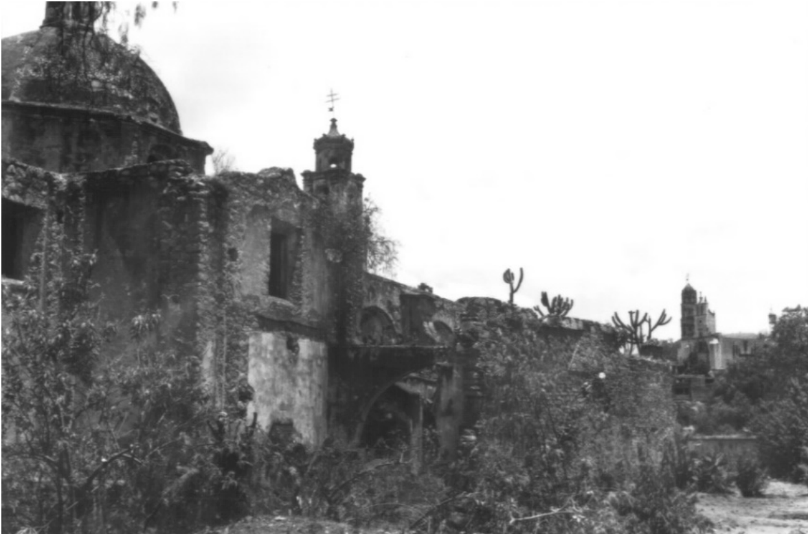
Ilustración 12 Estado de deterioro y abandono del Templo de San José y Santiago.
